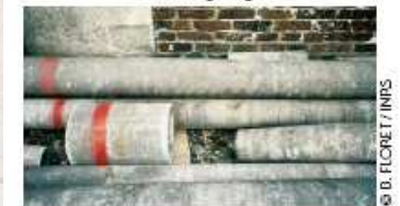
Canalisation en amiante-ciment
